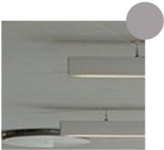
Kontorslandskap och mötesrum Nedpendlat undertak med synligt bärverk. ECOPHONE (volcanic ash). Kulör: NCS S 2002-Y (lika undertaksplatta)
