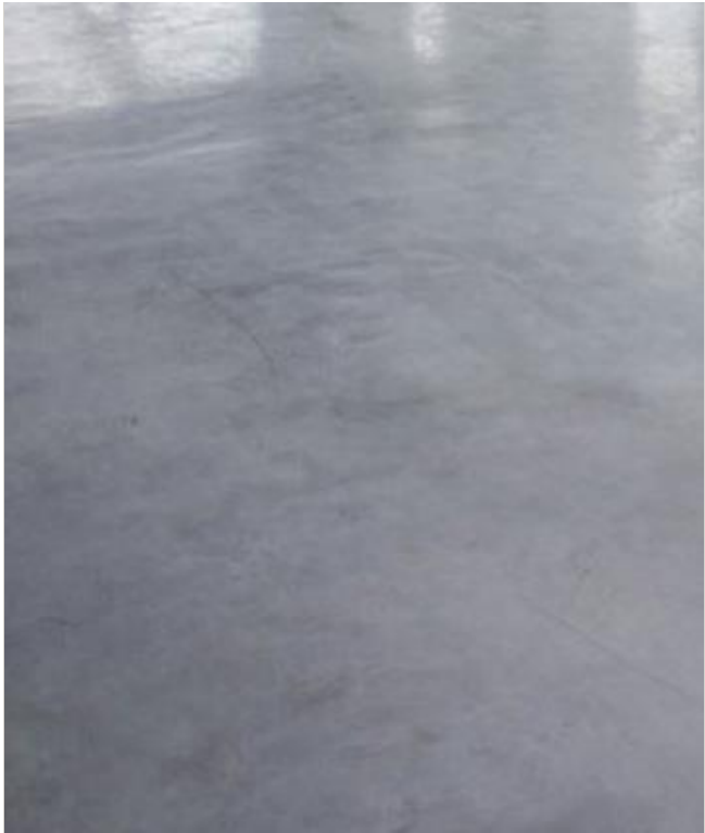
Kontorslandskap, korridor, pausyta, personalrum, pentry MODERN BETONG – putsat betonggolv, naturlig kulör
